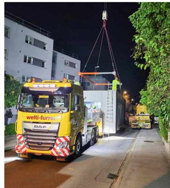
Durch Sondertransport geliefert und mittels Kran in den Garten gehievt.
